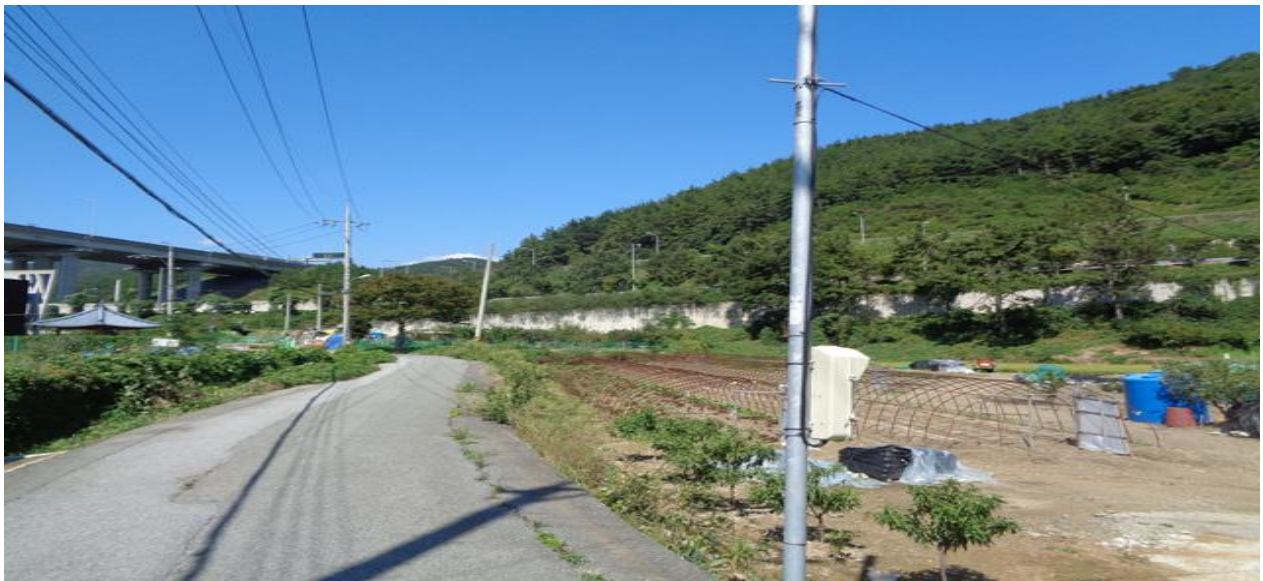
대상 콘크리트옹벽 전경
