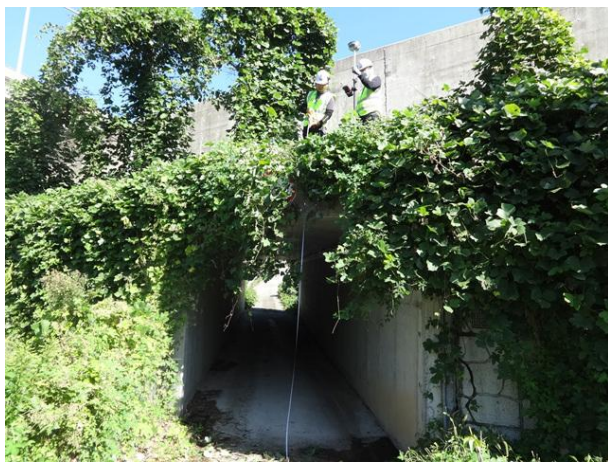
GPS측량기를 이용한 선형 및 수준측량
