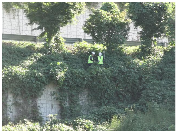
GPS측량기를 이용한 선형 및 수준측량
