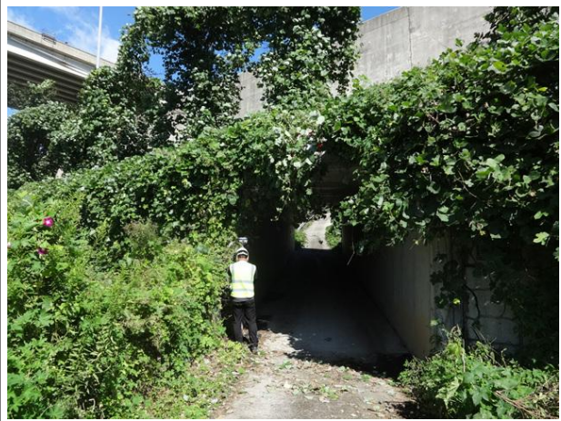
GPS측량기를 이용한 선형 및 수준측량
