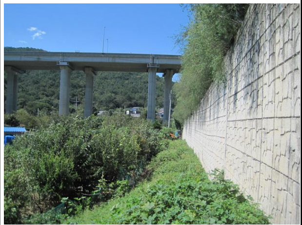
종점부 사면 및 콘크리트 옹벽 시공상태
