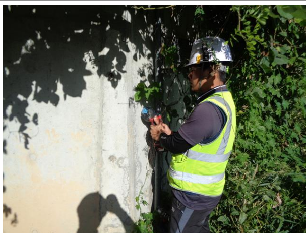
콘크리트 강도조사(반발경도시험) 전경
