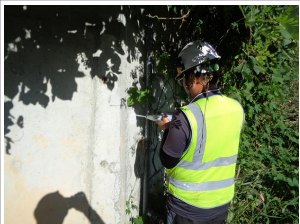
콘크리트 강도조사(반발경도시험) 전경
